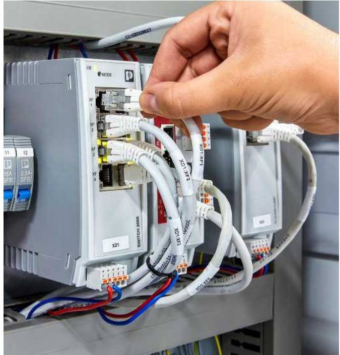
Etiquetas envolventes de cables adecuadas para aplicaciones interiores y exteriores
